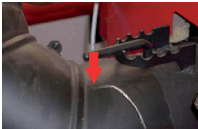
Установка датчика температуры дымовых газов
