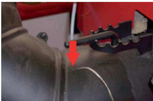
Установка датчика температуры дымовых газов
